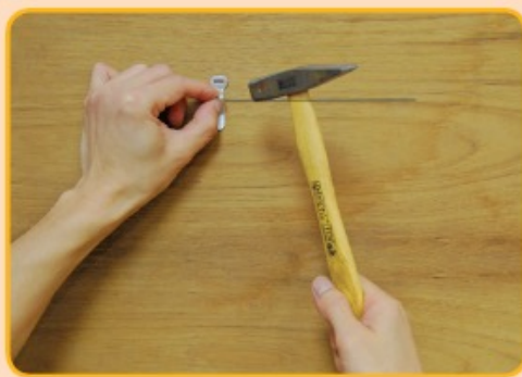
ตอกเข็มขัดรัดสายไฟฟ้า
