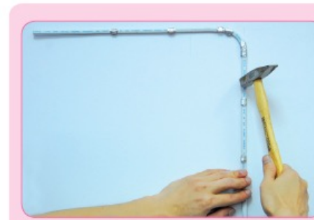
ใช้ค้อนเคาะแต่งแนวสายไฟฟ้า
