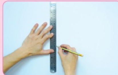
ใช้ไม้บรรทัดเหล็กช่วยในการลากเส้นเป็นแนวเดินสายไฟฟ้า
